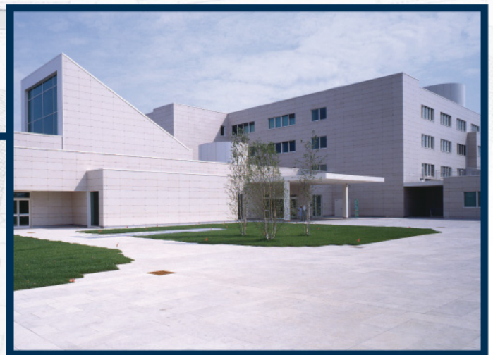
Centro di Ricerca e Didattica Universitaria Via Manzoni 113 (building 7)
